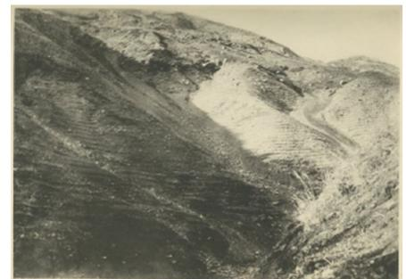
(解説)斜面を階段状に成形した宣筋工を3ha施工
