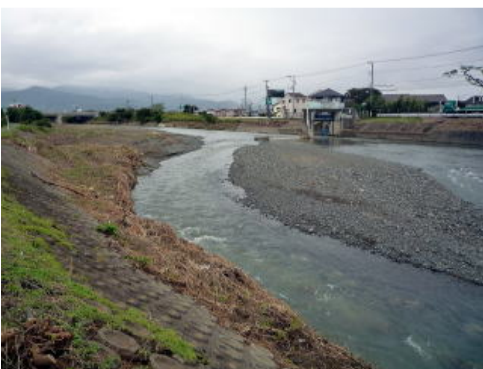
台風19号から4日後、金目川「飯島堰」右岸の爪痕残る
