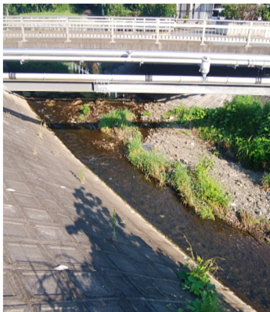
脇橋の少し下流右岸から上流(脇橋)を見る
