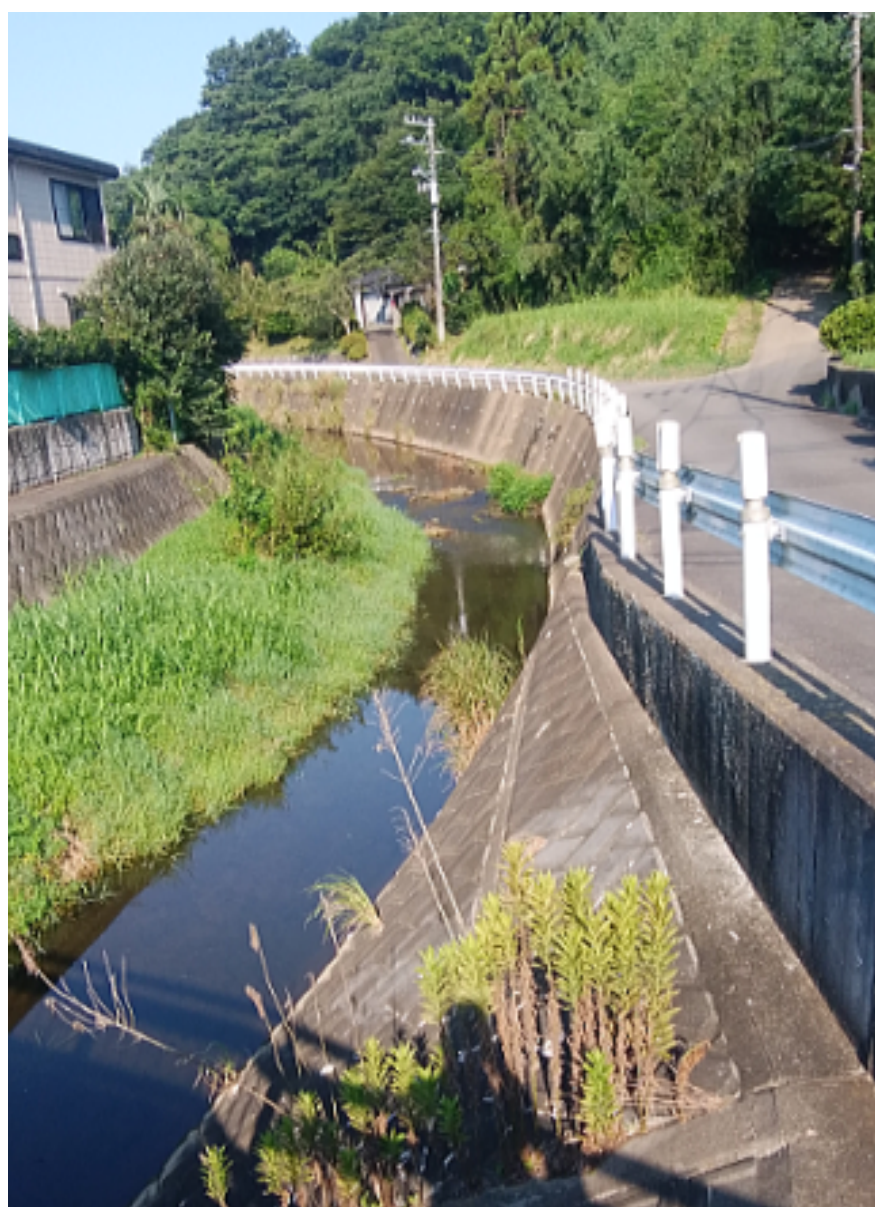
脇橋の上から座禅川上流を見る
